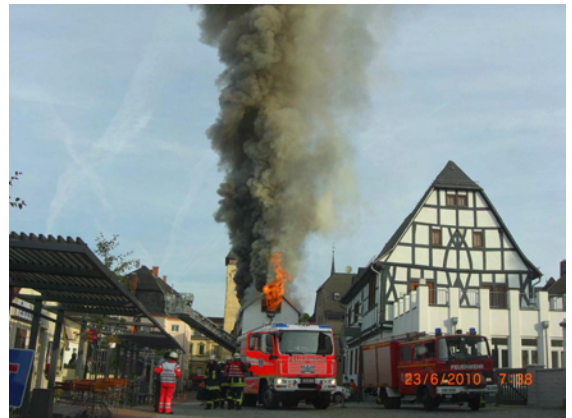
Dachstuhlbrand in der Altstadt von Bad Camberg
