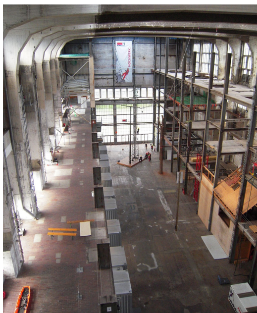
Blick von oben in die Übungshalle
