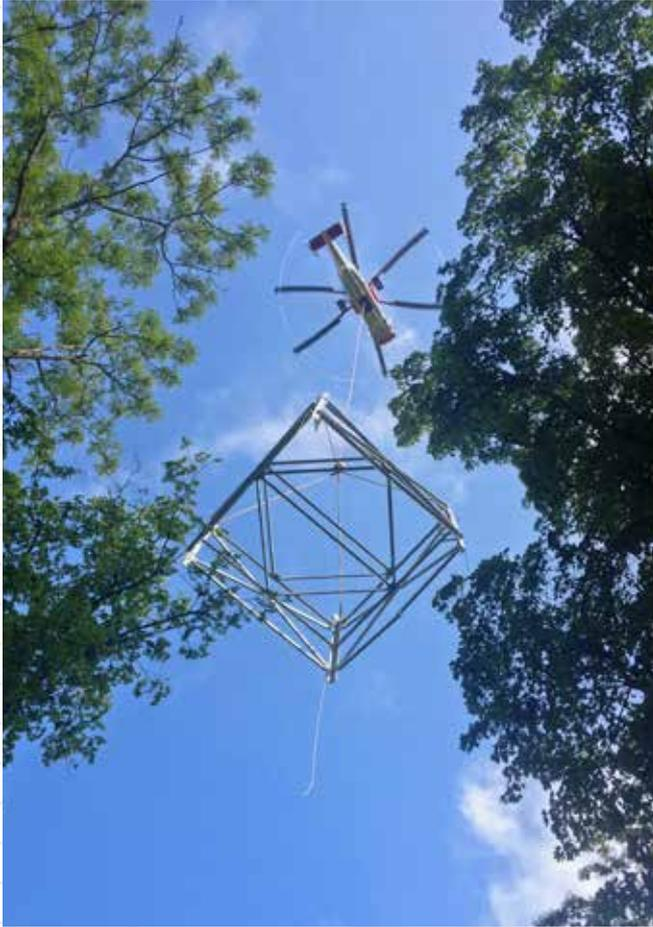
Aufbau eines Antennenmastes mit Hilfe eines Hubschraubers.
