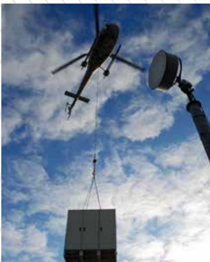
Hubschrauber mit Basisstation, Bild: AS BY.
